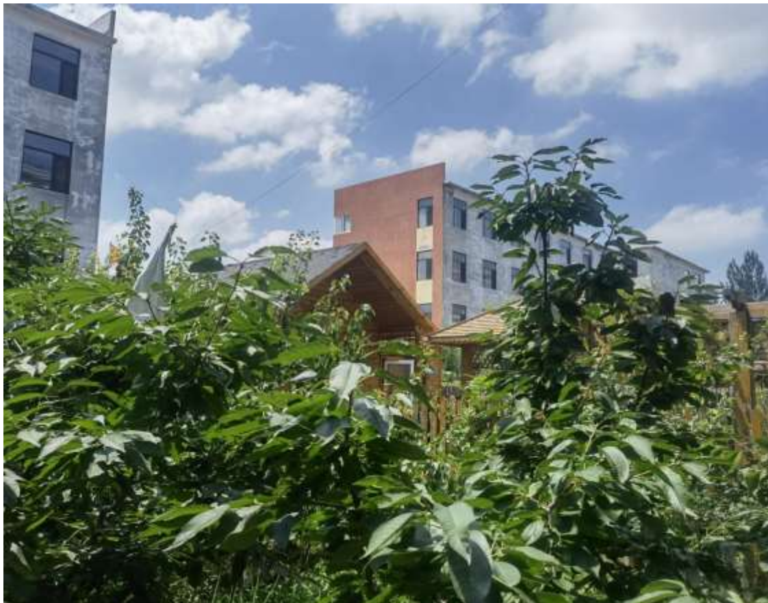
图 3.4-3 相邻地块现状照片
